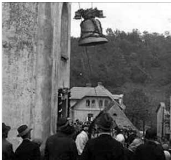
Vyzdvihování nového zvonu do věže kostela - 28. 5. 1933
